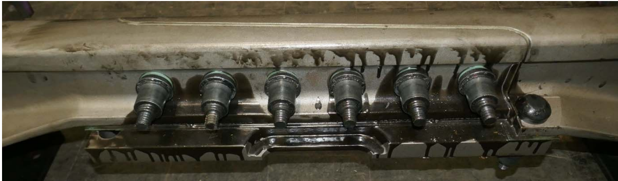
Abbildung 1: Ansicht der Isolierstoß-Konstruktion „ABJ“
