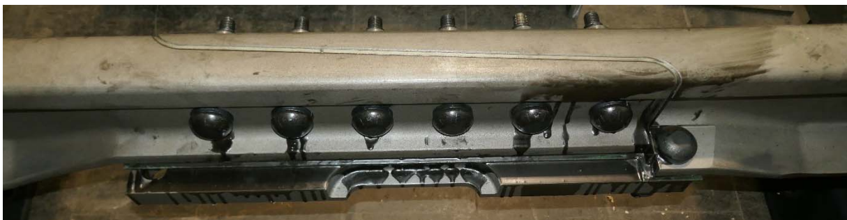
Abbildung 2: Gegenseitige Ansicht der Isolierstoß-Konstruktion „ABJ“
